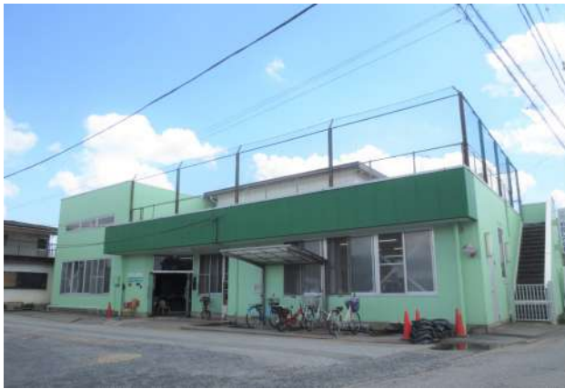
外壁塗装工事後のわらしべの家【令和6年7月撮影】
